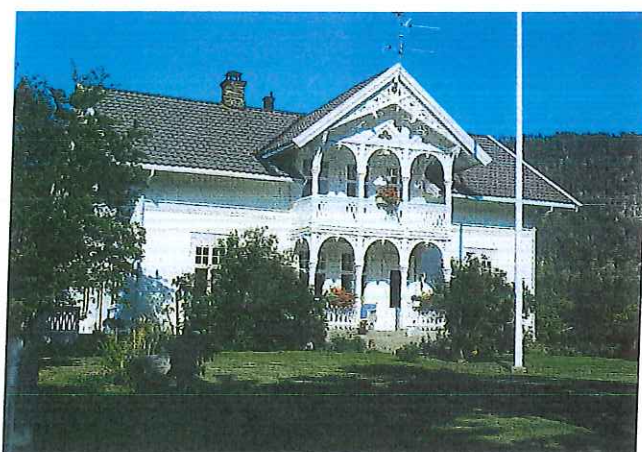
Den gamle landhandelen ved Tveit brygge er en representant for den karakteristiske sveitserstilen i bygda med rike detaljer rundt vinduer, gavler, verandaer, store takutspring og krysspostvinduer.
