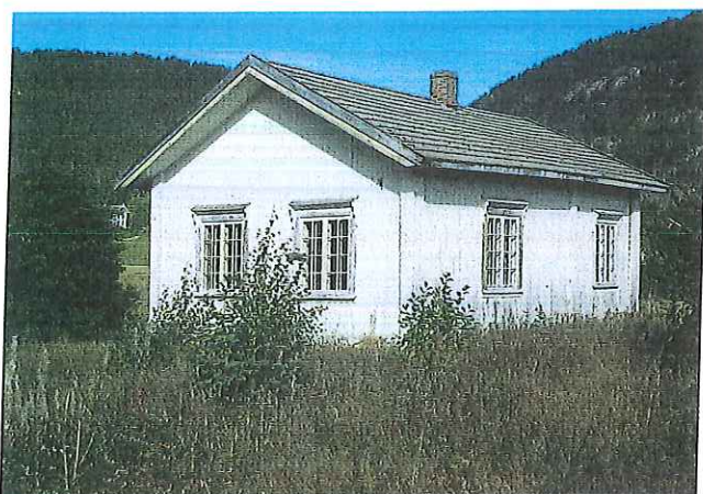
Flom skole er en av de få igjenværende eksemplere av denne typen skolestuer med et opprinnelig preg i kommunen. Via velvilje fra grunneier, dugnadsarbeid og støtte fra det offentlige, er bygningen igjen i ferd med å komme i aktiv bruk.
