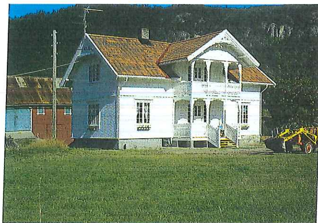
I hovedsak forskjellen i grunnmuren (betong, naturstein) viser at dette er en nyere, men velykka påbygging i sveitserstil.
