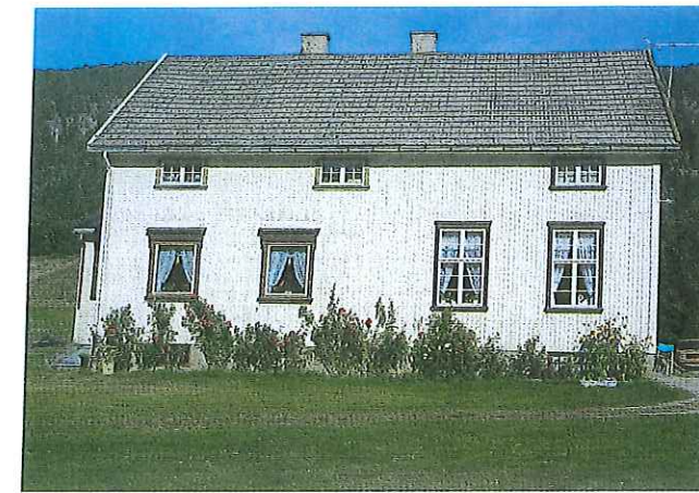
Her kan en forholdsvis enkelt få tilbakeført de opprinnelige, smårutete vinduene. Dette vil gi et opprinneligere preg til en fin bygning. Utskiftning av opprinnelige vinduer til funksjvinduer kjenner en til over hele landet og er en representant for sin tid.
