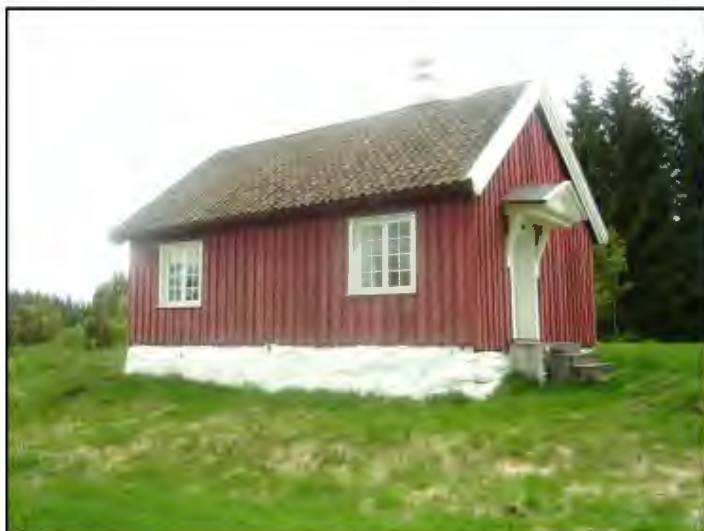
Figur 3.2: Jaktbu på Brennbu antas å være bygget i 1810 til eieren av Holden Jernverk, baron Eggert (Aga) Løvenskiold. Han var bosatt på Ulefoss fra 1812-1828, og var en ivrig jeger. Jaktbua er vedtaksfredet. Foto: Kulturminnesøk, Kai Ove Bjerkelund
