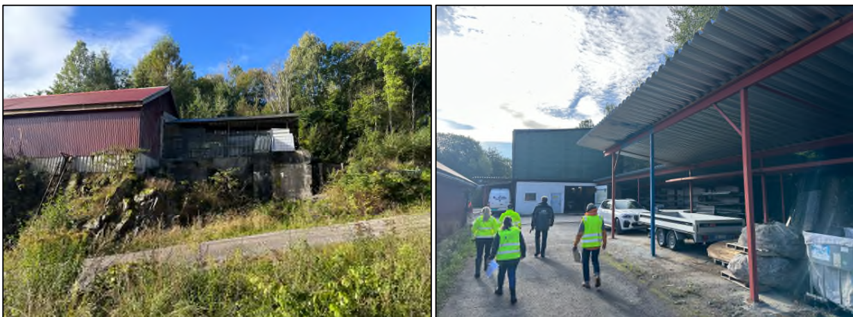
Figur 3-5: Bygg på verkstedet sett nedenfra og et overbygd utelager oppe på tomte til Ulefoss Mekaniske.
