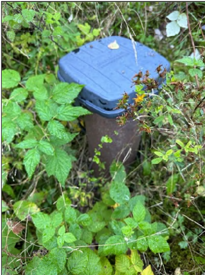
Figur 3-20: Grunnvannsbrønn i området.
