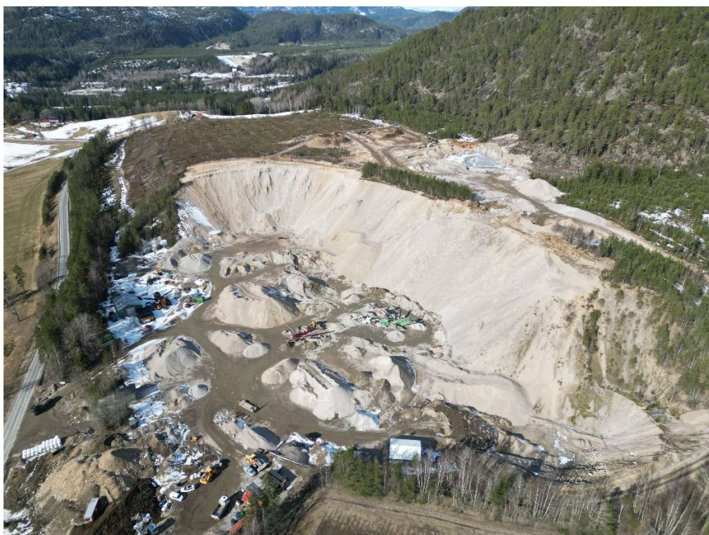
Figur 6: Området er naturlig skjermet for innsyn fra vestgående retning og noe mindre fra sør og østgående retning. (kilde: Planhuset as)
