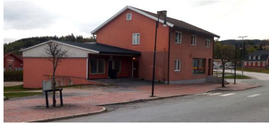
Fig. 6: Eksisterende bygg mot Ringsevja. Bygget planlegges revet. Bildet viser oppmerket Gangfelt og kantparkering i Ringsevja.
