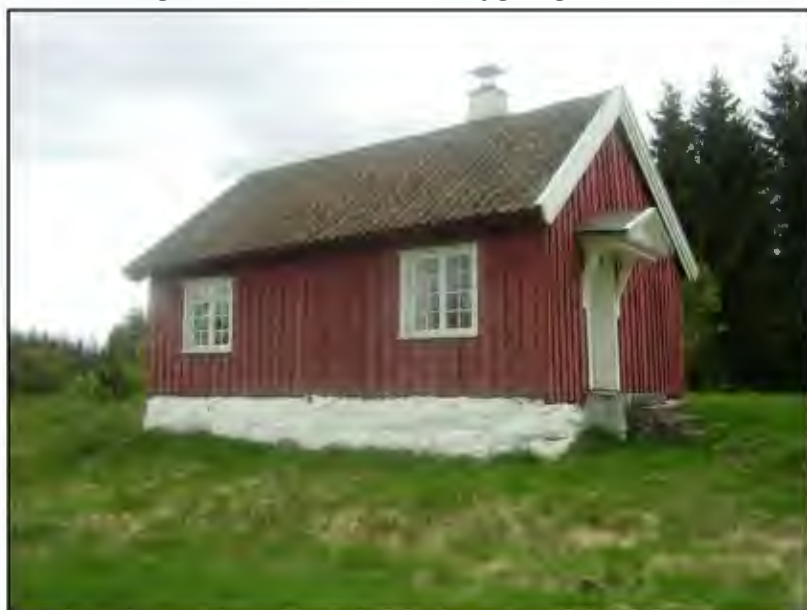
Figur 3.12: Jaktbu på Brennbu antas å være bygget i 1810 til eieren av Holden Jernverk, baron Eggert (Aga) Løvenskiold. Han var bosatt på Ulefoss fra 1812- 1828, og var en ivrig jeger. Jaktbua er vedtaksfredet. Foto: Kulturminnesøk, Kai Ove Bjerkelund
