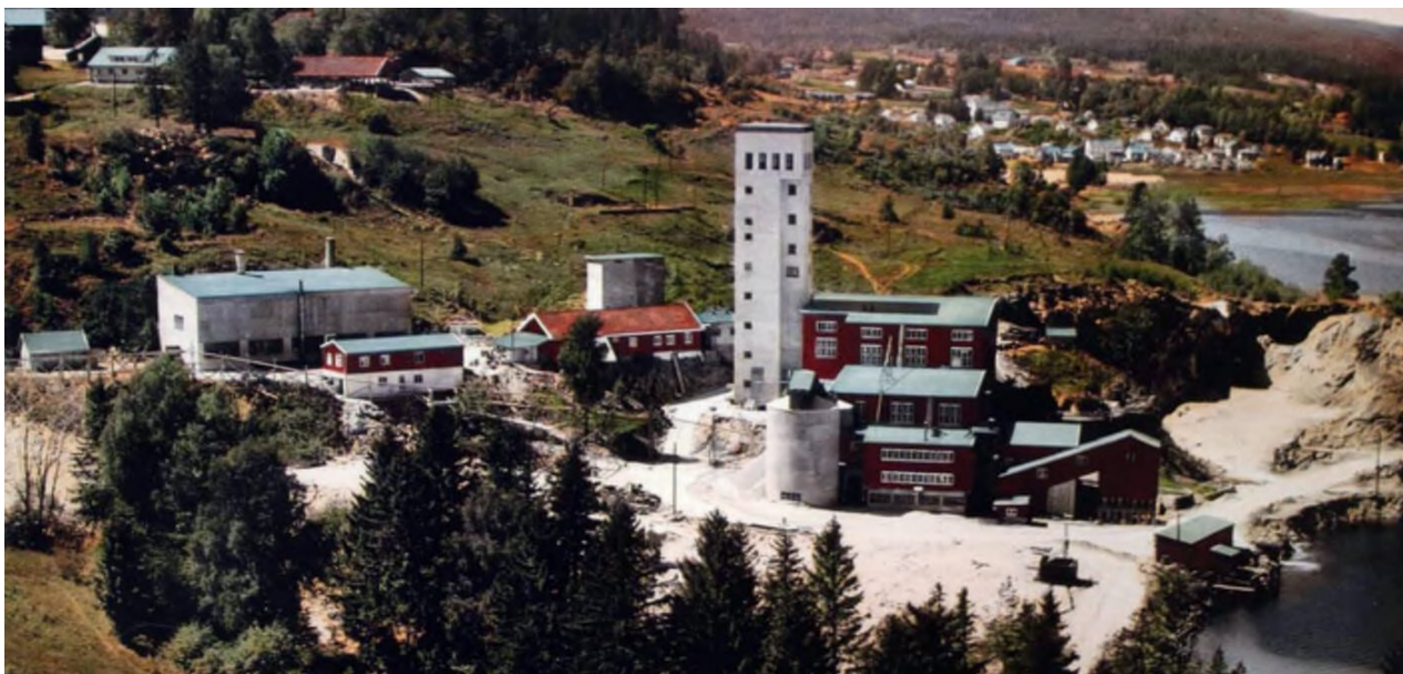
Figur 1-2 Oversiktsbilde over anlegget på 1950-tallet
