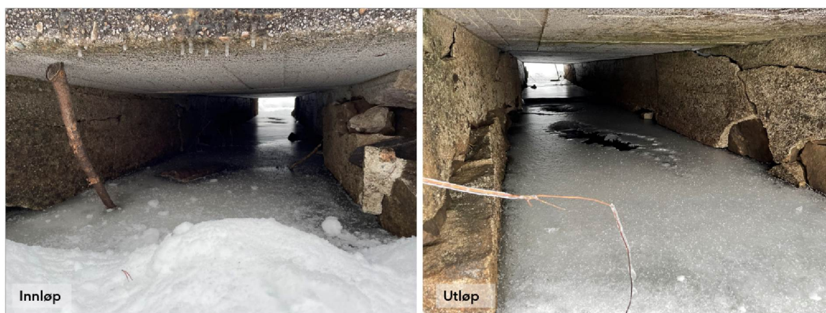
Figur 3-2: Innløp og utløp av stikkrennen nært utløpet i Øvre Stavsjø. Betongkonstruksjonen er 8.5 m lang, innløpet er 39 cm høyt, 90 cm bredt og utløpet er noe større. Foto: Asplan Viak januar 2022.
